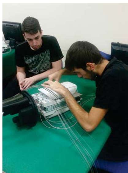
Allestimento delle muffole
