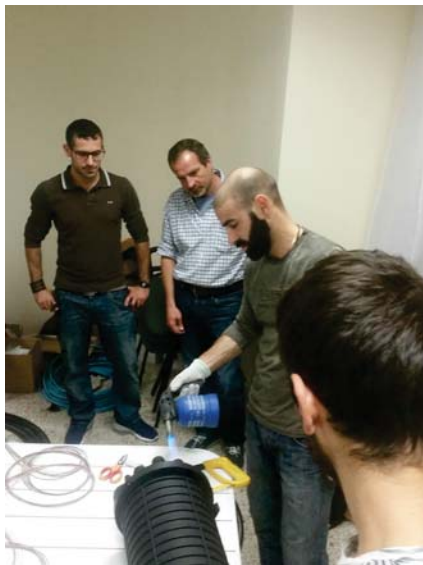
Cablaggio delle muffole
